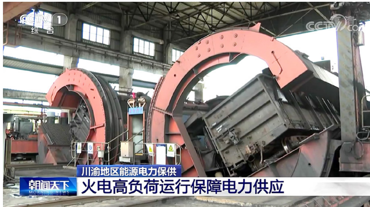
重庆公司战高温保供电情况被央视等多家媒体报道
