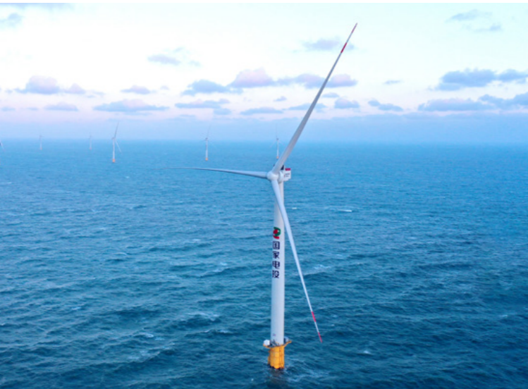
全球商用最大单机容量海上风电——神泉二海上风电项目全容量并网
