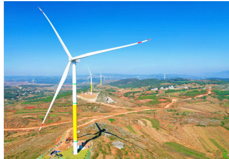
我国山地风电最大单机容量风机——云南国际富源西风电项目首台风电机组成功并网发电
