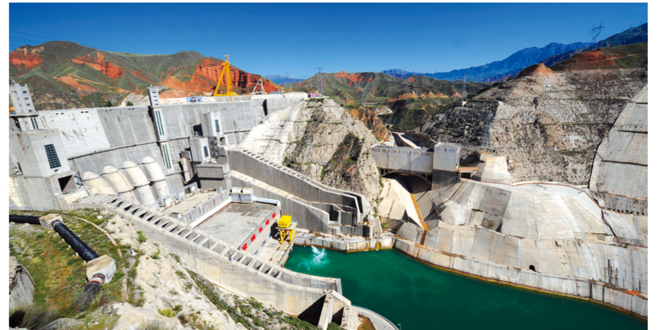
我国首次采用双排机布置的水电站——李家峡水电站，预计 2023 年 9 月并网发电，届时将实现 200 万千瓦全容量投产
