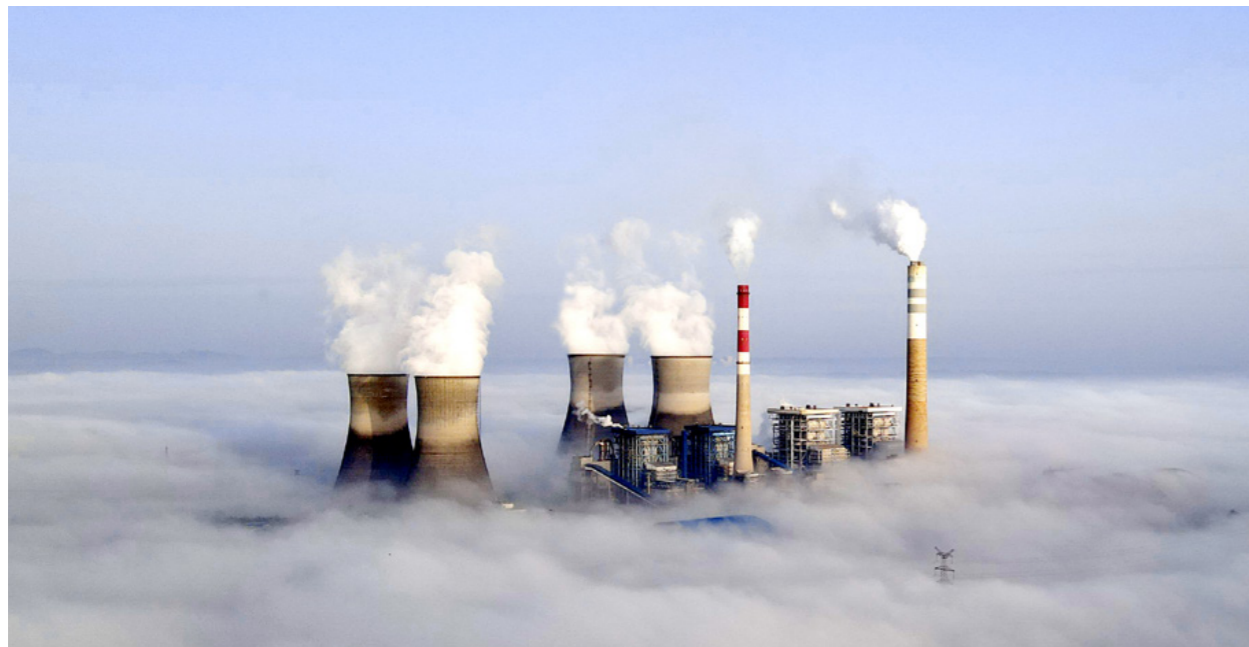
重庆公司合川双槐电厂建成我国首个燃煤电厂万吨级二氧化碳捕集装置，捕集纯度高于 99.5%，捕集效率可达 99%
