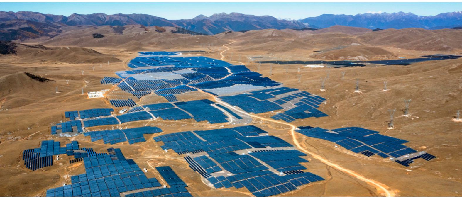
全球首个超高海拔光伏实证基地——甘孜兴川实证光伏电站投产
